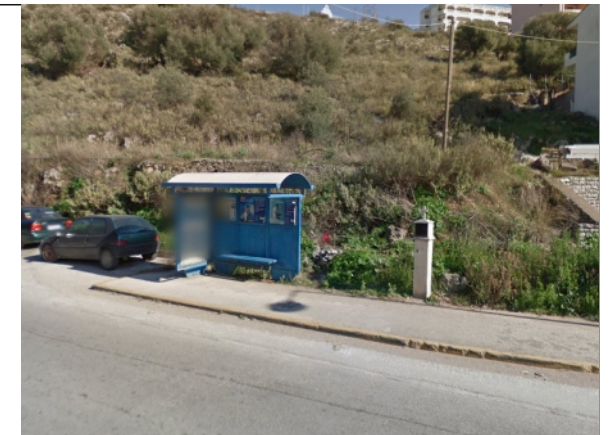
Φωτογραφία Σημείου Τοποθέτησης Στεγάστρου
