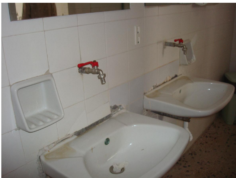
Εικόνα 7. Τουαλέτες Λύκειο Αμφιλοχίας
