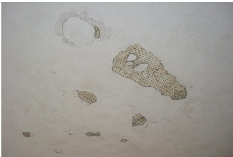
Εικόνα 10. Λεπτομέρεια οροφής πυλωτής Λυκείου Αμφιλοχίας
