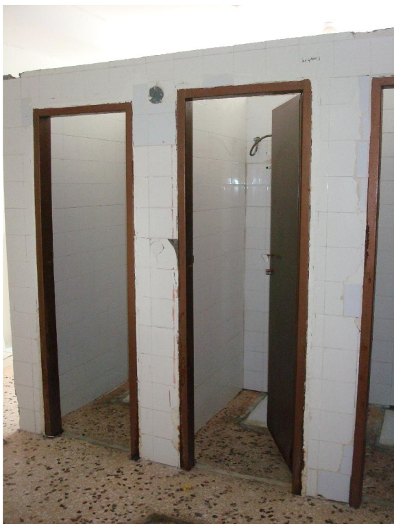
Εικόνα 8. Τουαλέτες Λύκειο Αμφιλοχίας
