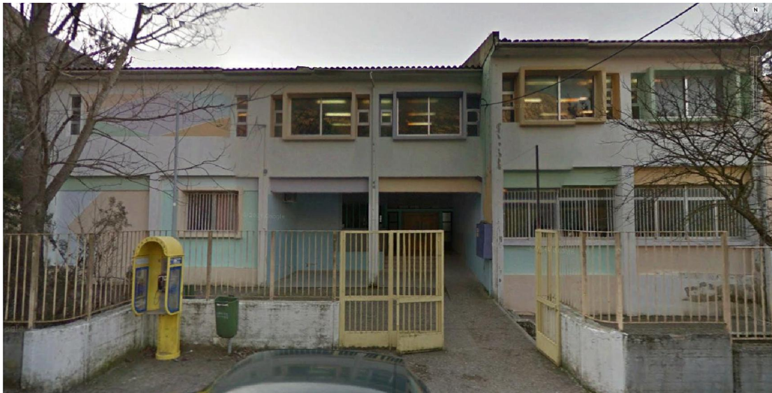
Εικόνα 2. Βόρεια Όψης Λυκείου Εμπεσσού
