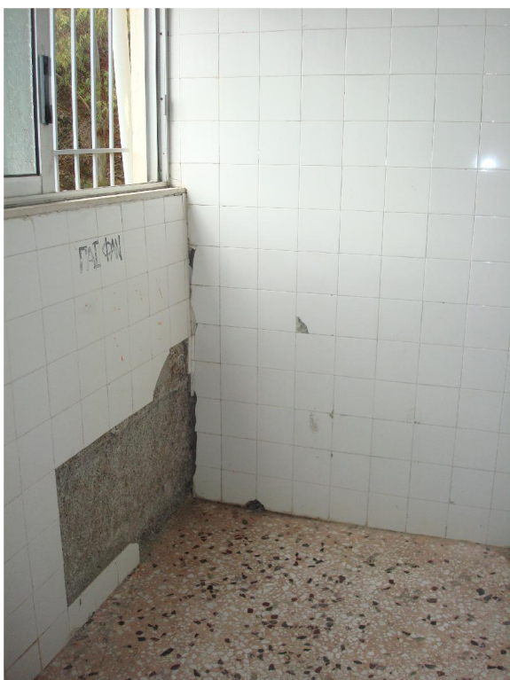
Εικόνα 9. Τουαλέτες Λύκειο Αμφιλοχίας
